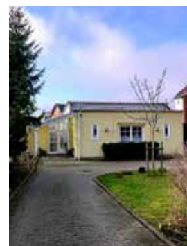
GEMEINDEHAUS Bahnhofstr. 11a, Bückeburg
